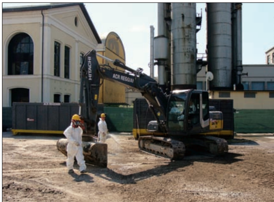
Figura 1: Operazioni pre-scavo terreno contaminato
