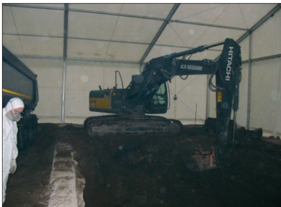
Figura 2: Operazione di scavo terreno contaminato
